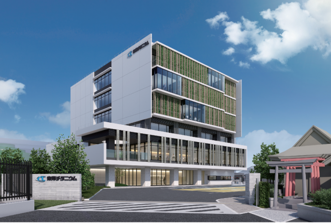
JR北茅ヶ崎駅側の外観イメージ（2階縦ルーバーはチタン製）
