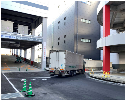
建物間中央部
