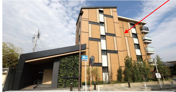
エントランスには壁面緑化を設置、外壁に外断熱サイディング
