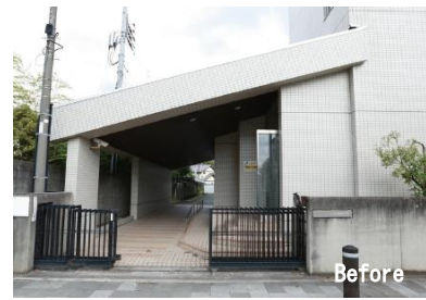
改修前は車路
