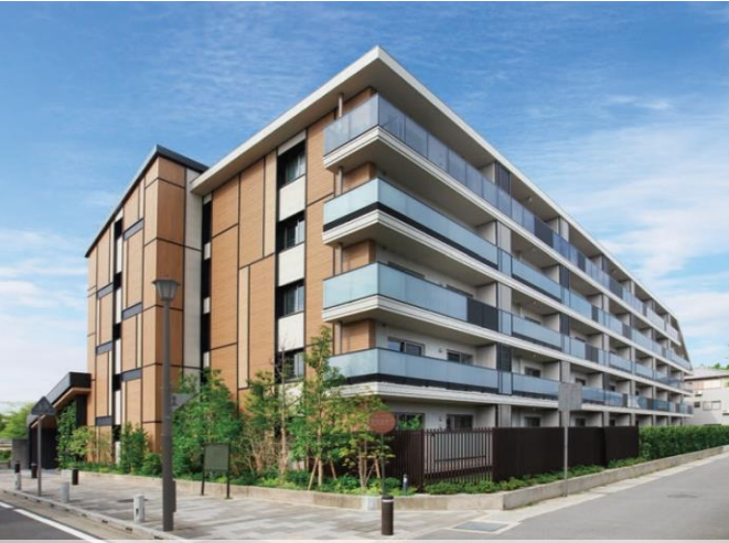
外断熱サイディングとガラス手摺に室外機目隠しパネルをランダムに配置し外観を一新。外壁と5階の手摺にも太陽光パネル。
