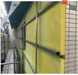
外壁に断熱材
