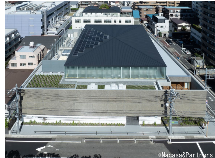
西側の屋根に設置した太陽光パネル
