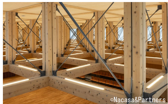
武道場の屋根を支える木造立体格子
