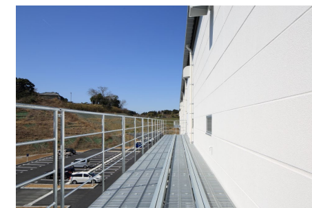
設備バルコニー
