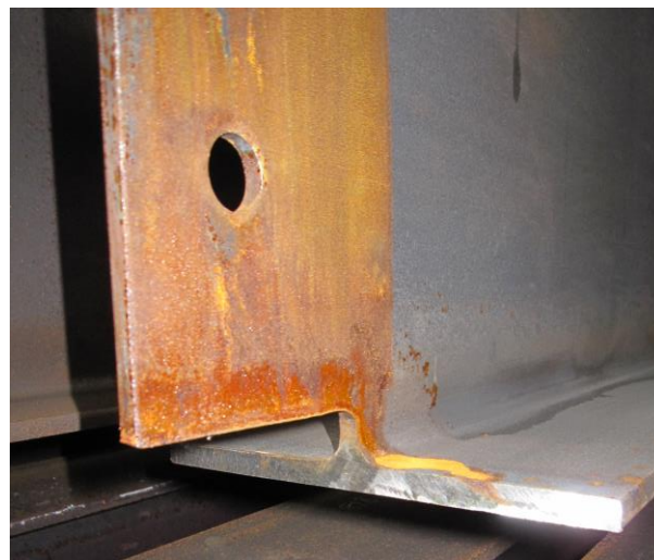
下フランジ両側切断の事例
