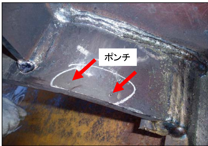
ハンチで曲げ加工される外表面 (写真はポンチを打って曲げ加工された後)
