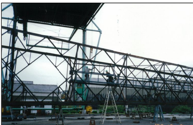
送電鉄塔の仮組
