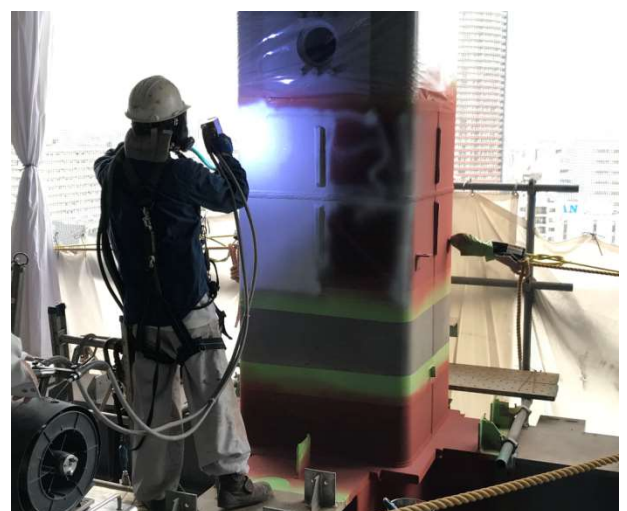
常温金属溶射の作業状況
