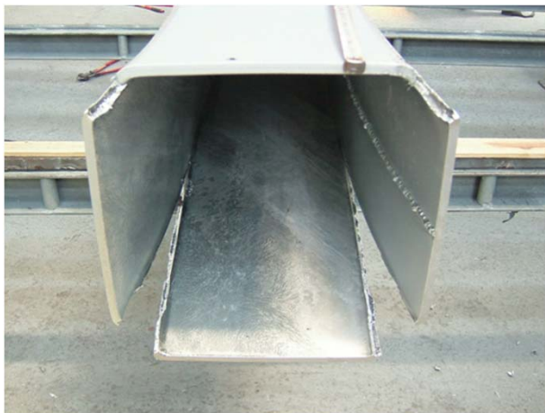
角形鋼管のめっき割れ事例
