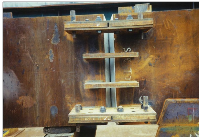
仮組時の現場溶接部精度の確認
