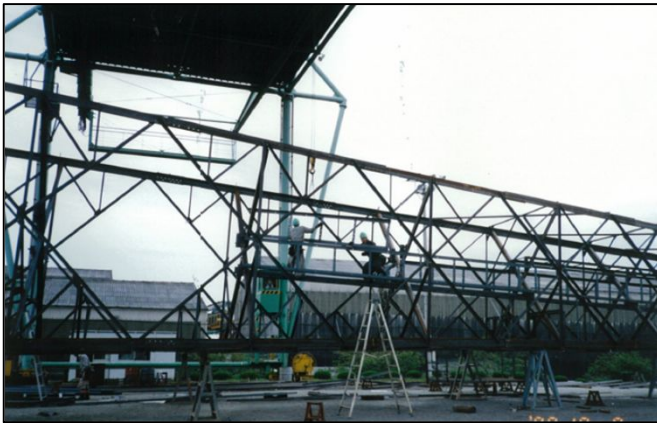
送電鉄塔の仮組
