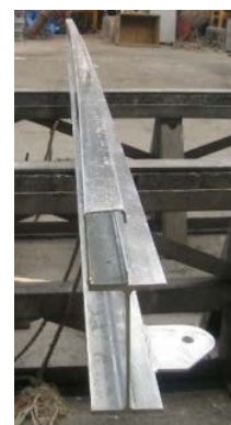
上部片側にだけ部材を溶接したため曲がりが生じた例
