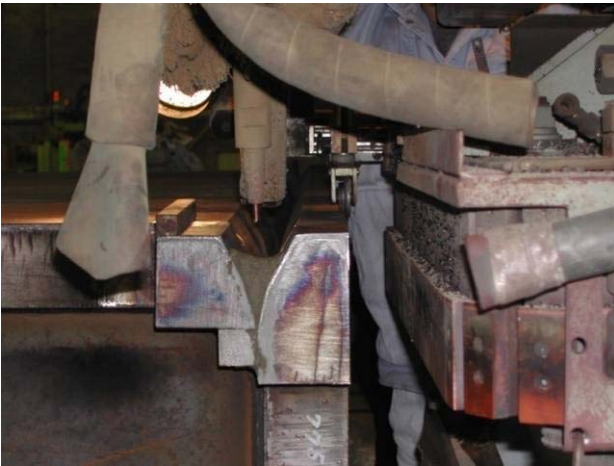
大電流サブマージアーク溶接
