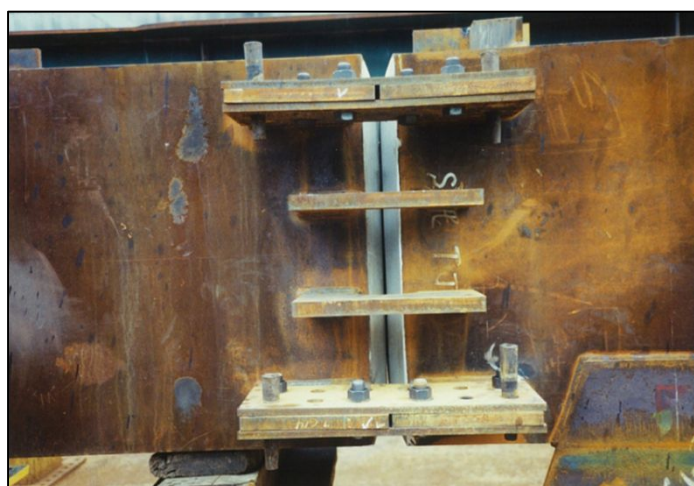
仮組時の現場溶接部精度の確認
