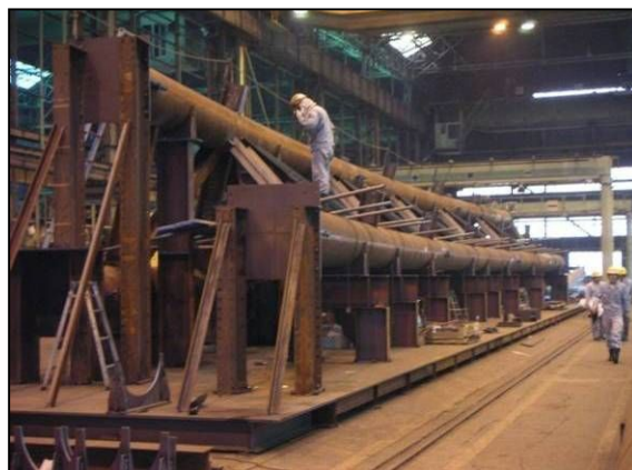
鉄骨トラスの仮組 (トラスの長さやせいの寸法確認)
