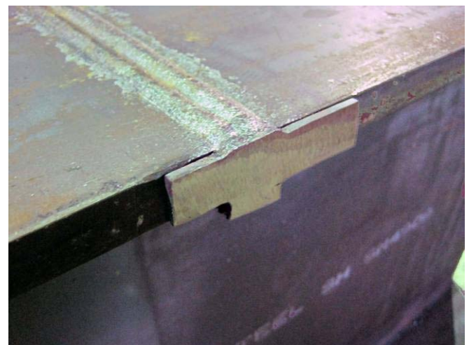
エンドタブ切断後、グラインダ仕上げの例※
