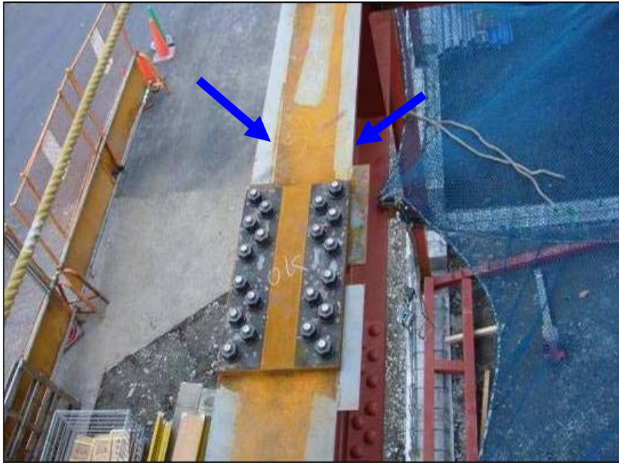
梁フランジのデッキかかり代を下塗りした例
