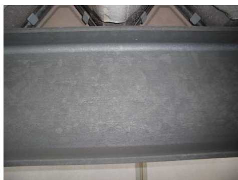
経年変化による光沢が低下した部材
