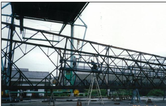
送電鉄塔の仮組
