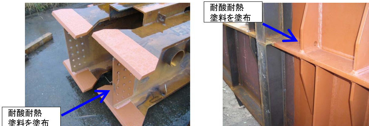
耐酸耐熱塗料の塗布例
