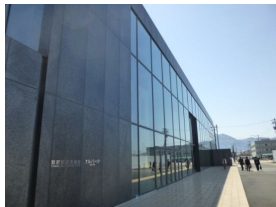
りん酸亜鉛処理施工例 2
