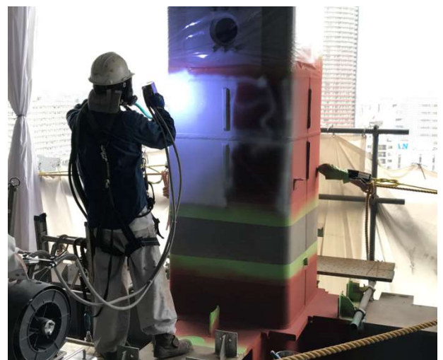
常温金属溶射の作業状況
