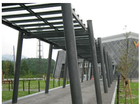
りん酸亜鉛処理施工例 3
