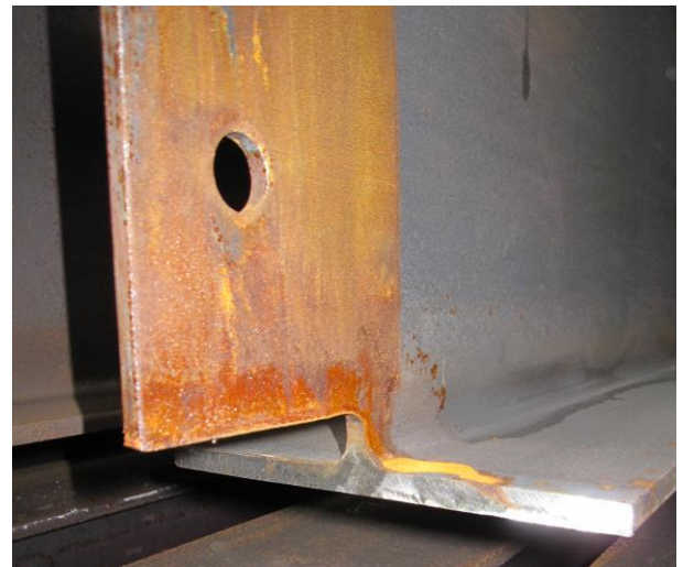
下フランジ両側切断の事例
