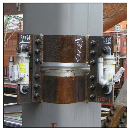
油圧式 (固定は通常の高力ボルト締め)
