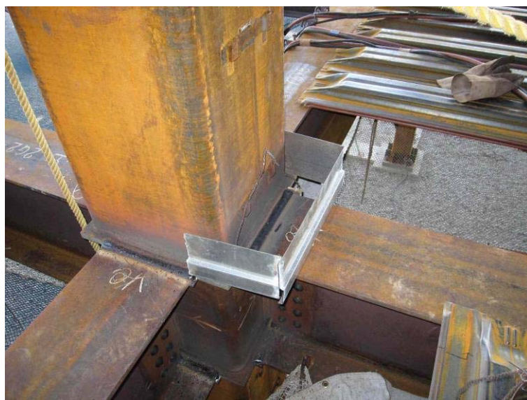
溶接部近傍のみを囲う防風装置の例
