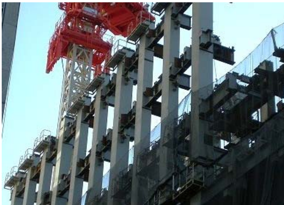
外周部鉄骨の防せい塗装例
