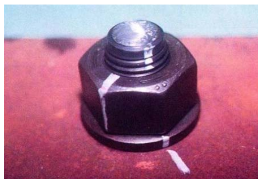
本締め完了時
