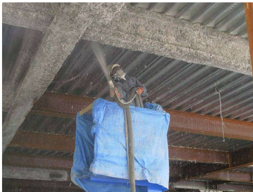
吹付けロックウール施工状況
