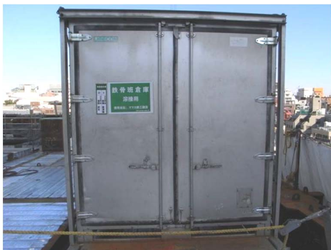
溶接材料保管用のコンテナ
