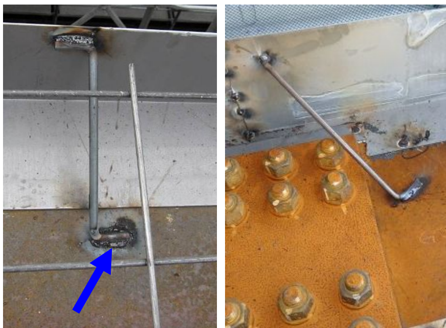
ショートビードを避けるZ形(左)、L形(右)のコンクリート止め控え
