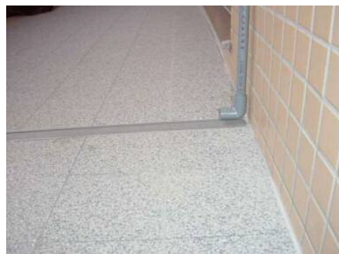
ドレン配管 長尺シート部分ドレンレール施工例
