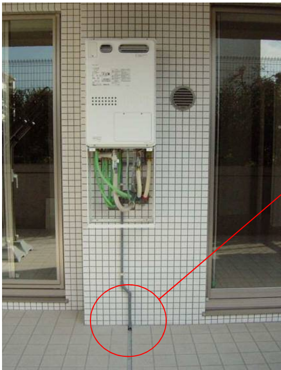
給湯器取付及び下部配管状況
