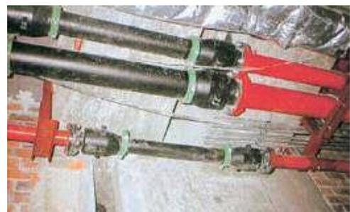
クローザージョイントは、フレキシブルジョイントのようにL字型の配管をする必要はない。
