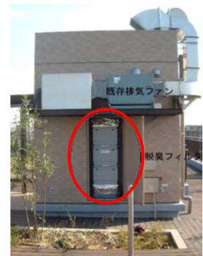
小規模タイプ対応例 (某シルバーマンション共用厨房用) Q=1,600m 3 /hr
