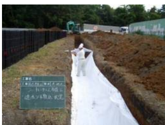
掘削・透水シート敷設
