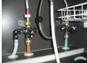
止水栓施工例
