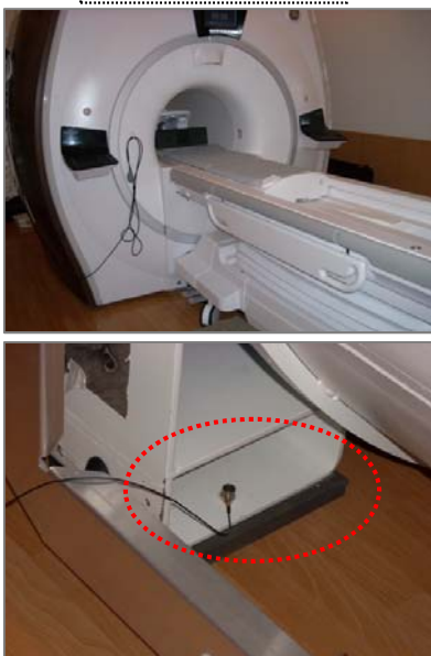
MRI防振施工事例
