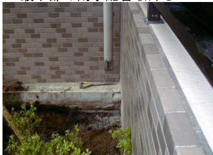
雨水立て管と1階雨水配管を分離
