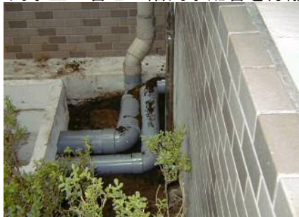
雨水立て管と1階雨水配管を分離
