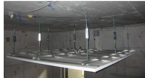
図 1 吊り天井の一例
