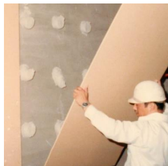
図 1 セっこうボード直貼り工法の施工
