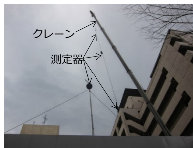
図 2 建設地での騒音測定の例
