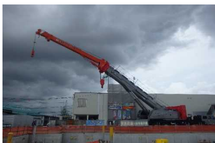
ラフタークレーンによる施工
