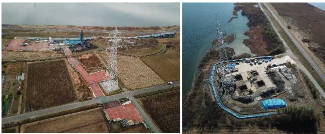
ドローン画像による現場状況確認
