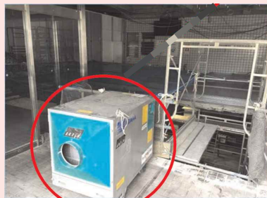
集塵機を設置し室内の換気を実施
