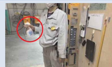
EVの操作盤等の消毒を徹底
