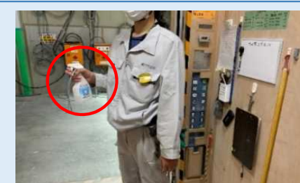
EVの操作盤等の消毒を徹底
