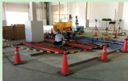
工事エリアの区画を設定して作業
