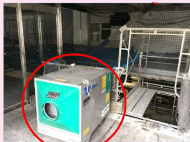
集塵機を設置し室内の換気を実施
