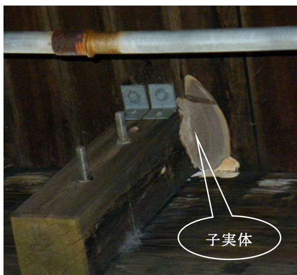
写真 2.2.6 木材腐朽菌の子実体の事例
