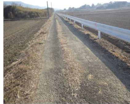
写真：舗装の劣化進行が著しい区間
