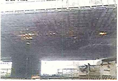
【②下り線 足場下】 撮影日: 3/20 3/20 14:30
