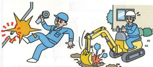
ガス管の位置を確認せずに工事を行うとガス管を損傷し、ガス漏れやガス爆発事故に至る場合があります。
