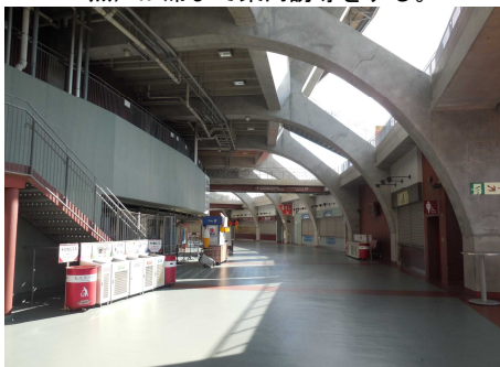
F 球場内を1周するコンコース (3階) 平坦で十分な幅(内野12m、外野8m)のコンコース沿いに、飲食売店、多機能便房、車いす使用者用観覧席等が設けられている。
