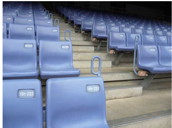
・観覧席に設置された転倒、転落防止の 役割を果たす、手がかりの部品
