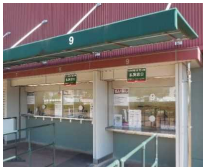
E サービスカウンター 車いす使用者用カウンターを併設している。
