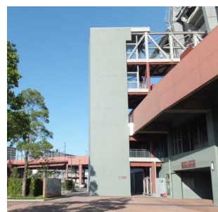
D 大型エレベーター 利用者アンケートに基づき、3階のコンコース・観覧席に至るエレベーター(26人乗 高齢者・障害者優先)を2014年に増築した。
