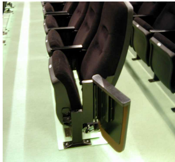
・客席端部のいすの水平可動式の手すり (高 齢者、障害者等が利用しやすいよう、開いた 状態)
