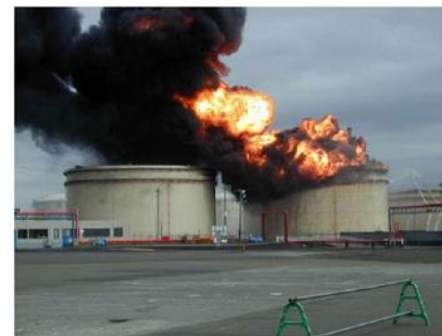
平成15年十勝沖地震による石油タンクの被害
