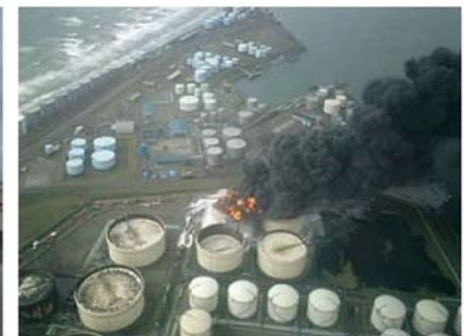
平成15年十勝沖地震による石油タンクの被害
