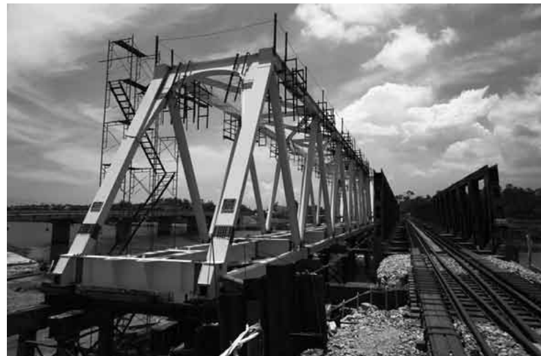
切り替え準備が進むBaBau橋
