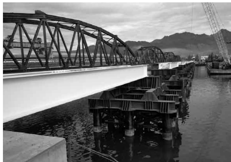
迂回仮橋の建設が進むNamO橋
