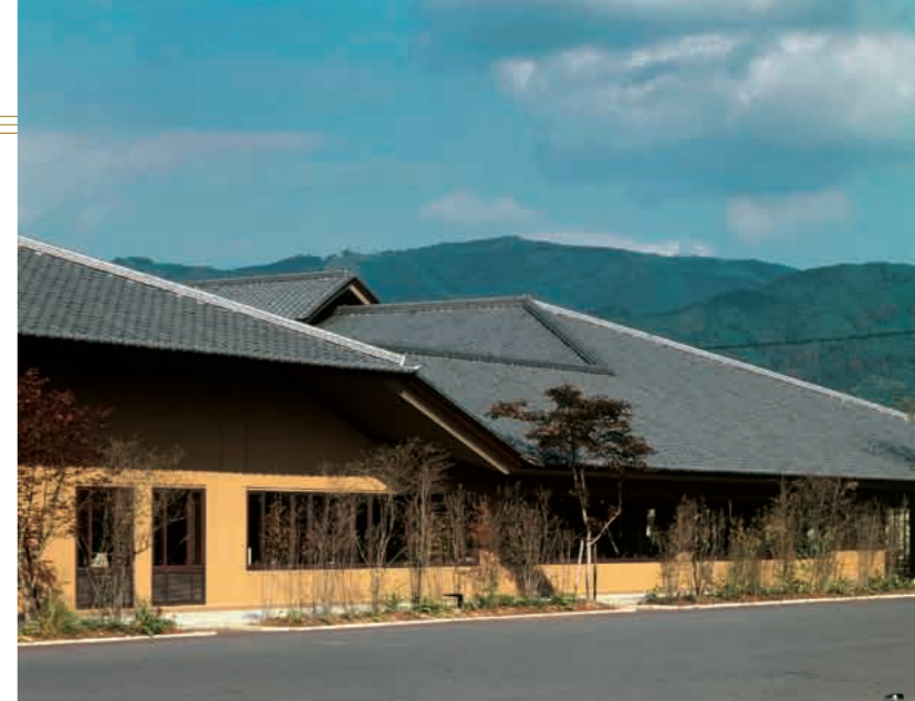
南側から屋根の重なりを見る。奥に見える三輪山の稜線を模して屋根にむくりをつけた。外壁の色は三輪の大地の色を表現している。(写真：村井 修)
