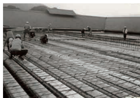
第三期・倉庫棟増床の屋根スラブ配筋工事の風景。中空スラブとするためのボイド管が並ぶ。ボイド管は設備ダクトとしても利用している。
