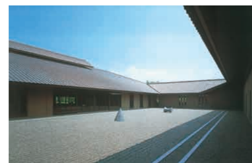
中庭。樋はなく瓦から直接落ちる水のすだれを風情として演出している。雨落ち部分は幅400mmの砂利敷きで内部に浸透管を設け雨水を処理している。
