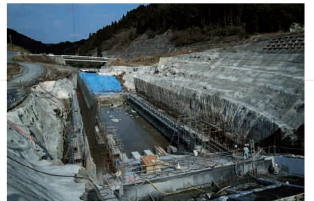
洪水を下流に放流する洪水吐、流れを安定させる静水池などのコンクリート構造物の建設も進む。
