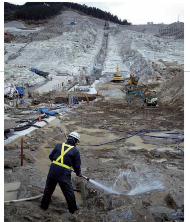
隆起した花崗岩の岩盤がダムを強固に支える。中央に穿たれた溝に監査廊が設けられる。
