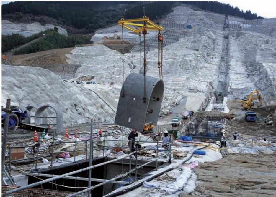
監査廊の施工には、型枠を兼ねたコンクリート二次製品を現場でつなぎ、上からコンクリートを打設するプレキャスト工法を採用。
