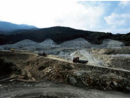
地山の上位法面では侵食や崩落を防ぐため少しずつ掘削し、その都度モルタルで補強した。原石山ではこれから採取される岩石が盛り立てのときを待つ。
