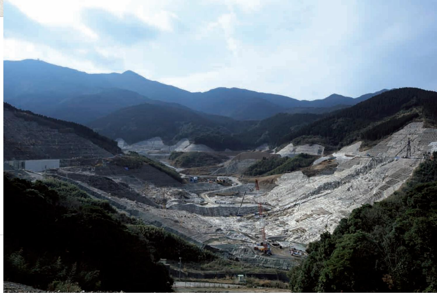
基礎掘削工事が終了し、全貌を現したダム底部。一級河川肝属川水系荒瀬川の水をせき止め、流域の鹿屋市、肝付町にまたがる1,537haの農地を潤す農業用水の水がめとなる。
