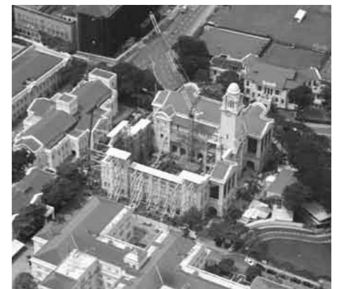
ビクトリアシアターおよびコンサートホール 鳥瞰 (施工中)
