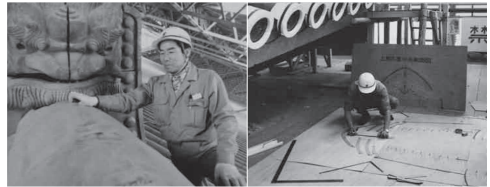
左/昭和48(1973)年に始まった東大寺大仏殿の修理現場で、屋根最上部にある大棟の原寸図を作成する若き日の山本会長。右/正確な図面を書くことの大切さは、師から学んだ重要な教訓の一つ。
