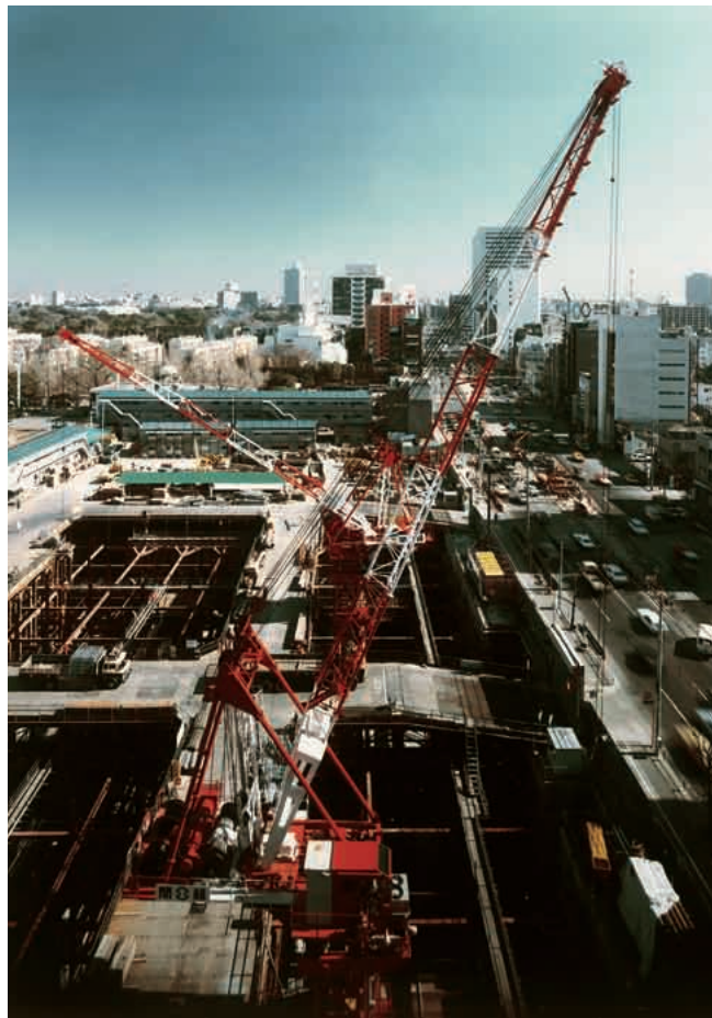
様々な条件のもと、周辺環境の対応や工事の効率を考えた工事。それにより安全性が高くなった。（提供：三輪晃久写真研究所）
