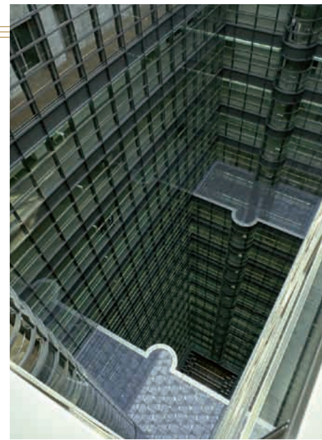
光庭によって消費電力を抑え、最少人数の残業にも対応できる換気の効果も併せ持つ。(提供:三輪晃久写真研究所)
