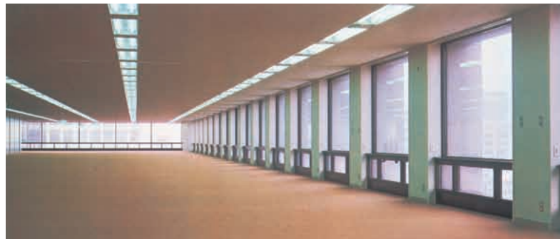
無柱空間は横のつながりが重要な商社にとって、大きな意味を持つものになっている。また、足元は開閉可能で換気などに役立っている。(写真:「伊藤忠商事株式会社 東京本社ビル」パンフレットより抜粋)
