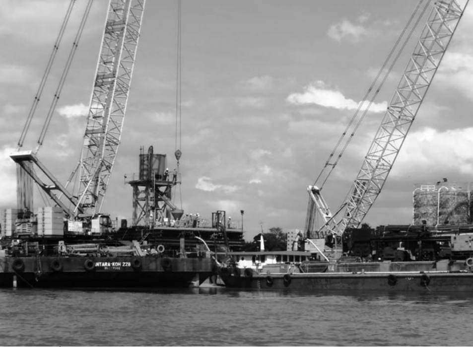
河川内での場所打ち杭施工状況
