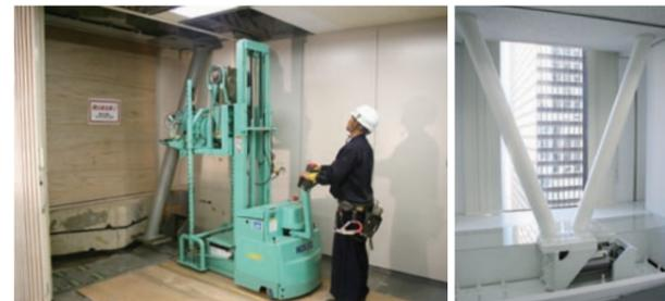
T-RESPO構法に用いられるオイルダンパー(右)により柱、梁、基礎の補強が不要となる。緊張材によりプレースを圧着させて既存架構に組み込むため、溶接も必要としない。建物を使用しながら地震対策を施すことが可能だ(左)。(提供：大成建設株)
