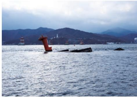
津波の越流を食い止め崩壊した湾口防波堤の“勇姿”。津波高も低減させたため、釜石の町は他の地区に比較して建物の倒壊が少なく、街並の面影も残すことができた。
