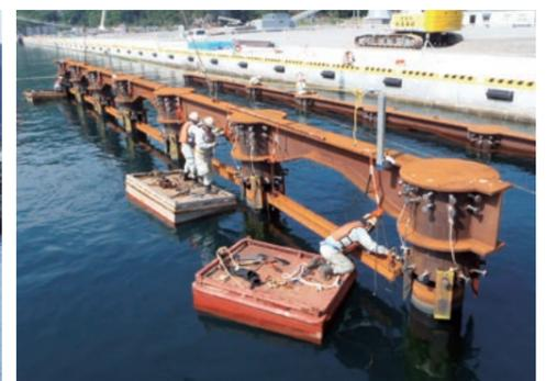
左/ケーソン海上打継場を結ぶ仮設棧橋の構築は、鋼管杭を打設し、工場製作された受桁・主桁を架設するジャケット方式を採用し、工期短縮に大きく寄与した工法だ。上/筏に乗っての手作業で、重さ約10kg/本のボルトは作業員によって着実に締め付けられる。
