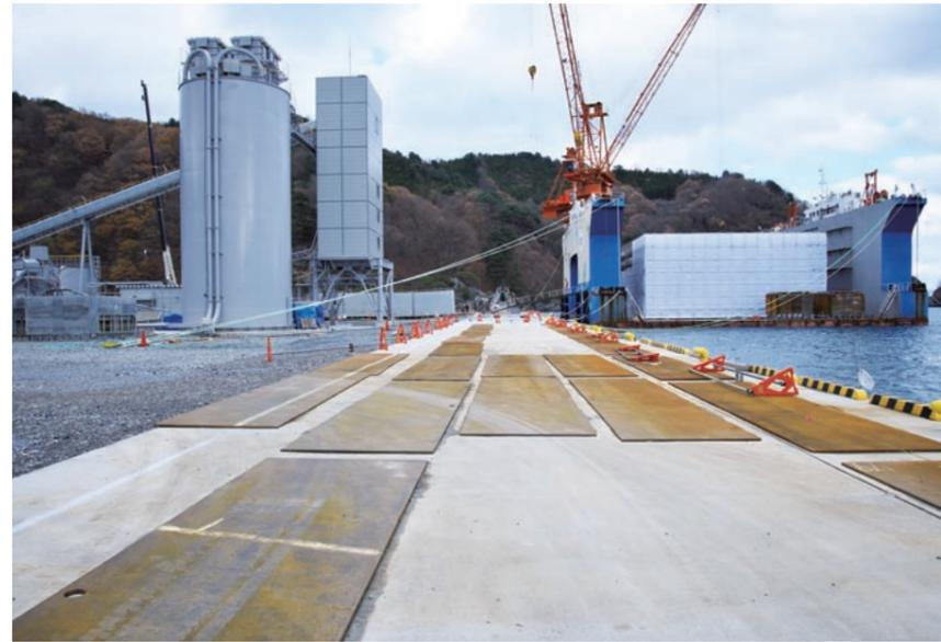
左に写る生コンプラントの建設も基地の整備と並行して進行。現場は完工した指定部分から次の工程に引き渡されていく。昨年7月中旬にはフローティングドックを係留できるように、ドック上でのケーソンの製作が始まっている。
