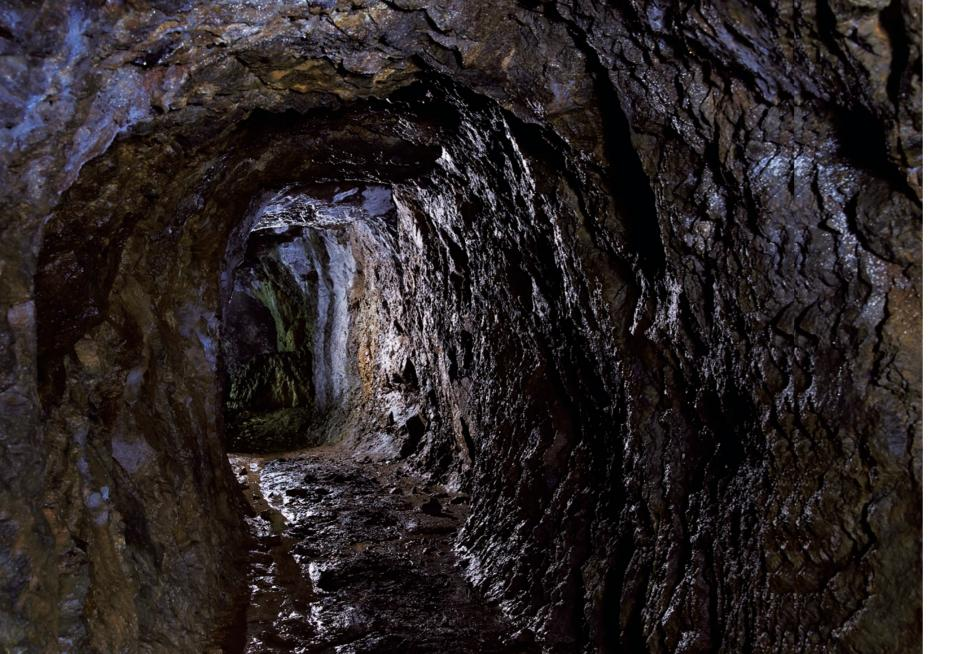
鶴子銀山で確認できる最大の坑道。鑿跡も残る。入口は滝の落ち口の裏側にある。鉱山は岩が安定してい るので、坑木がないのが特徴だ。周辺にある石積み擁壁のテラス遺構が盛況時を物語る。
