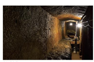
南沢疎水道 坑内排水用につくられた坑道で、高度な掘削技術と測量技術の証のひとつ。両端と 竪坑から掘り進む「向掘り工法」で、全長1kmを掘削した。当時、世界最高の技術と いわれる。
