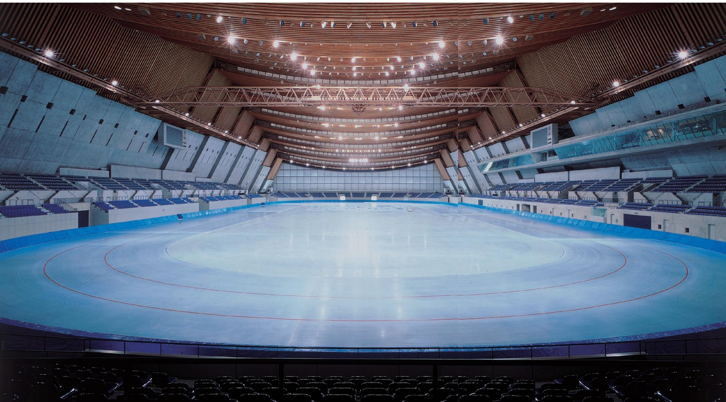
アリーナ内部。オリンピックでは、100mの直走路を持つスピードスケートのトラックとして使用された。集成材でつくられたM字の構造体が、80mのスパンの競技空間に架け渡されている。
