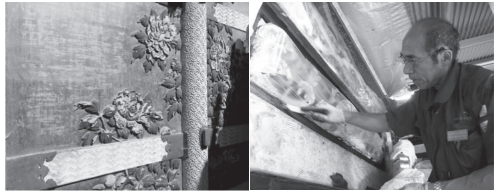
右/華やかな外観とは裏腹に、修復作業は漆塗りを何度も繰り返す地道な作業の連続になる。左/現在は彫刻になっているが、創建時点では絵画だったことが修復作業で判明した。
