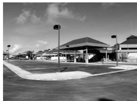
新ターミナルビルと駐車場
