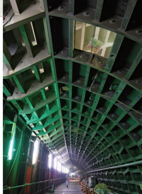
既設トンネルにはあらかじめ鋼製セグメントとのジョイント部「アゴ」が施されている(写真左上)。位置が微妙に変動するためその都度計測、ミリ単位で接合するピースを「オーダーメイド」した。
