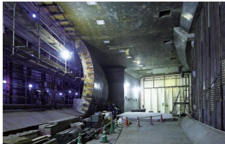
中央環状新宿線と連絡路との接続部。新宿線を供用させながら切開き工事を行う。シールドトンネルを開削工法で切開き合流部を構築する。
