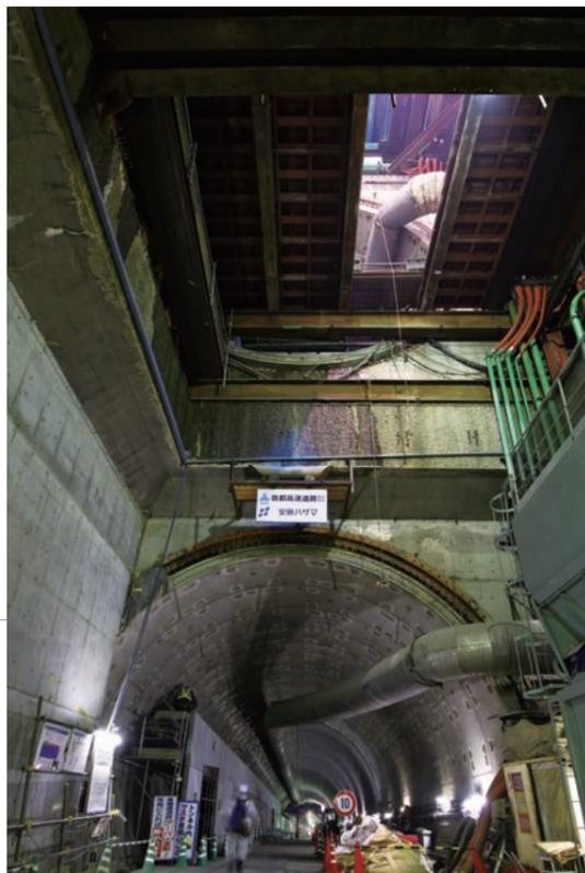
上下に縦列する連絡路。下層のトンネルを施工した後、シールドマシンの内部駆動部だけを引き抜きジャッキアップし、改めて上層のトンネルを掘進するDSR工法を採用した。
