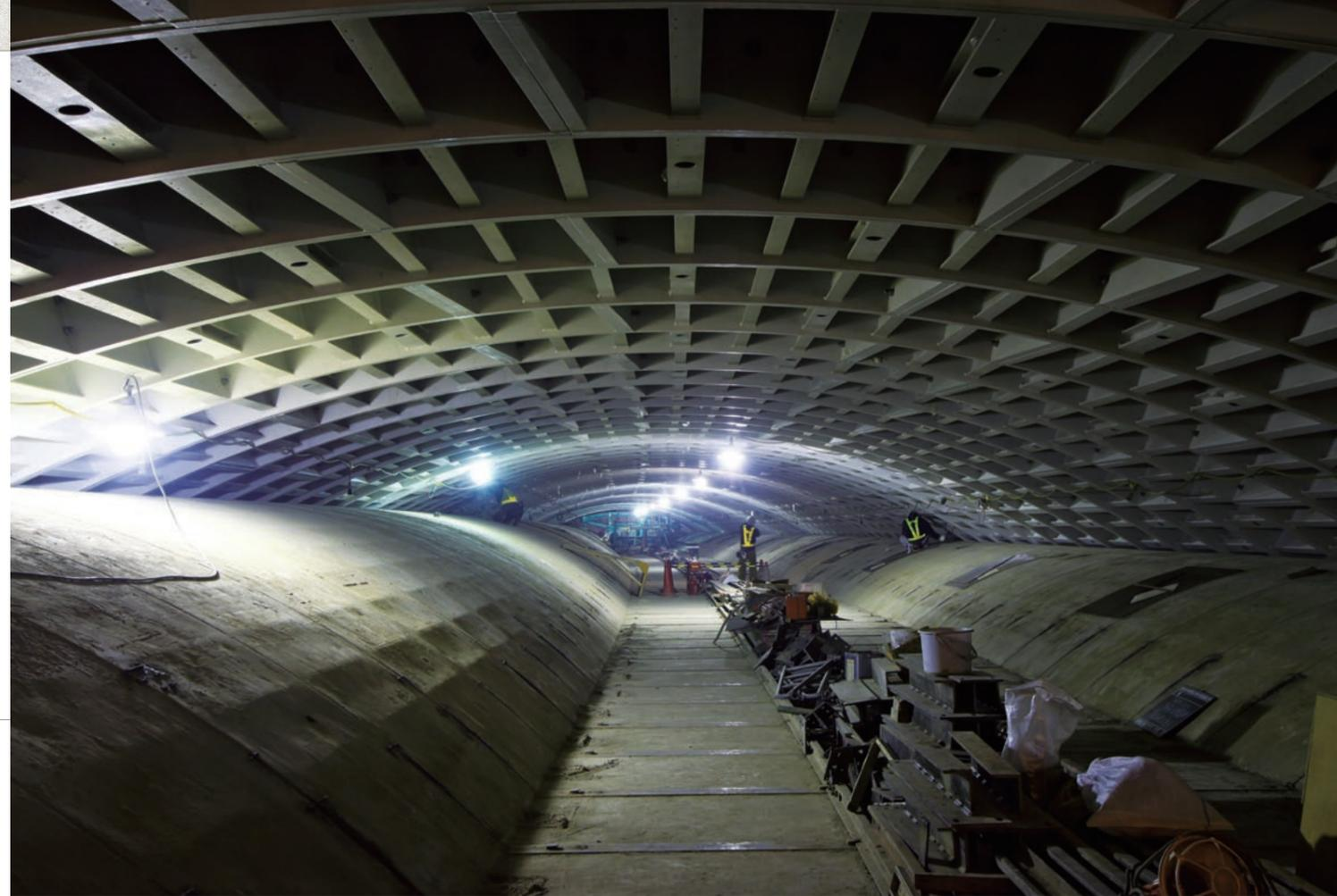
足元の左右に見えるのが本線と連絡路の外胴部。このセグメントを撤去して切開き、横方向に拡幅された大断面トンネルを構築する。
