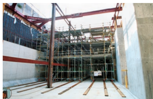
躯体を構成する175ブロックはほぼ同幅。レールの上を 移動できる可動式の支保工を採用し、施工性を高めた。
