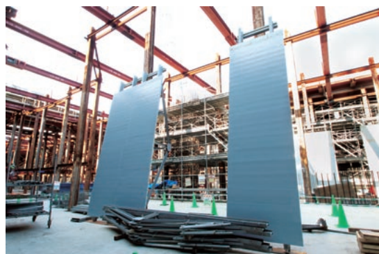
一回で設置できる高さ5mの型枠。従来の木製の型枠にあるセ パレータがないため地下水の漏水を抑止できる。
