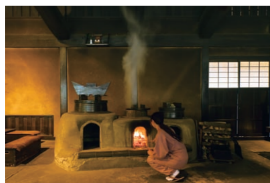
勾玉型のカマド。大小3つのカマドを使い勝手がよいように少し内側にカーブさせ、並べて設置した。
