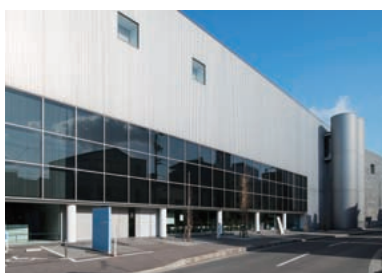
美術館の1階に丸亀市立中央図書館が併設されている。出入口は南側の道路に面する。猪熊氏の馬の絵を取り入れ、家具の色も猪熊氏のコーディネート。駅に近く入りやすいので多くの利用者がある。
