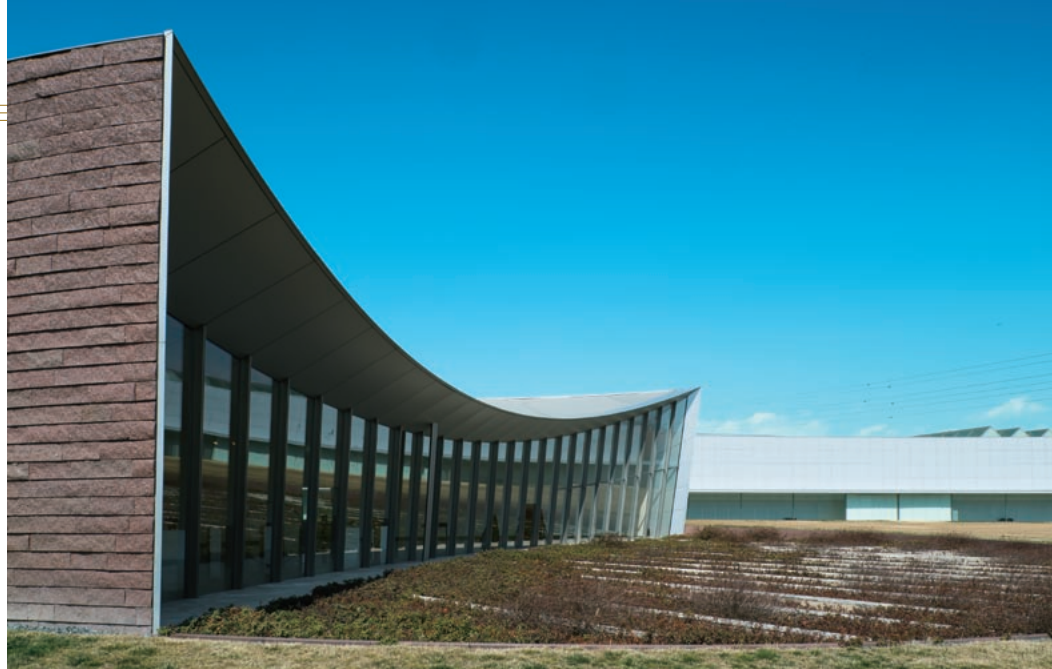
第1展示室の外観。曲面の屋根の底はアルミパネル。外壁も前面のガラスも上部を外側に5度傾けている。外壁は、アフリカンレッドの花崗岩を石積みのような表情に張っている。
