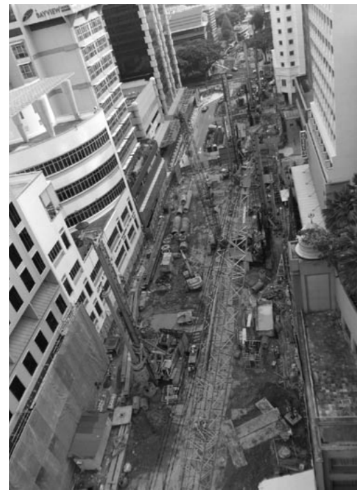
山留壁施工状況
