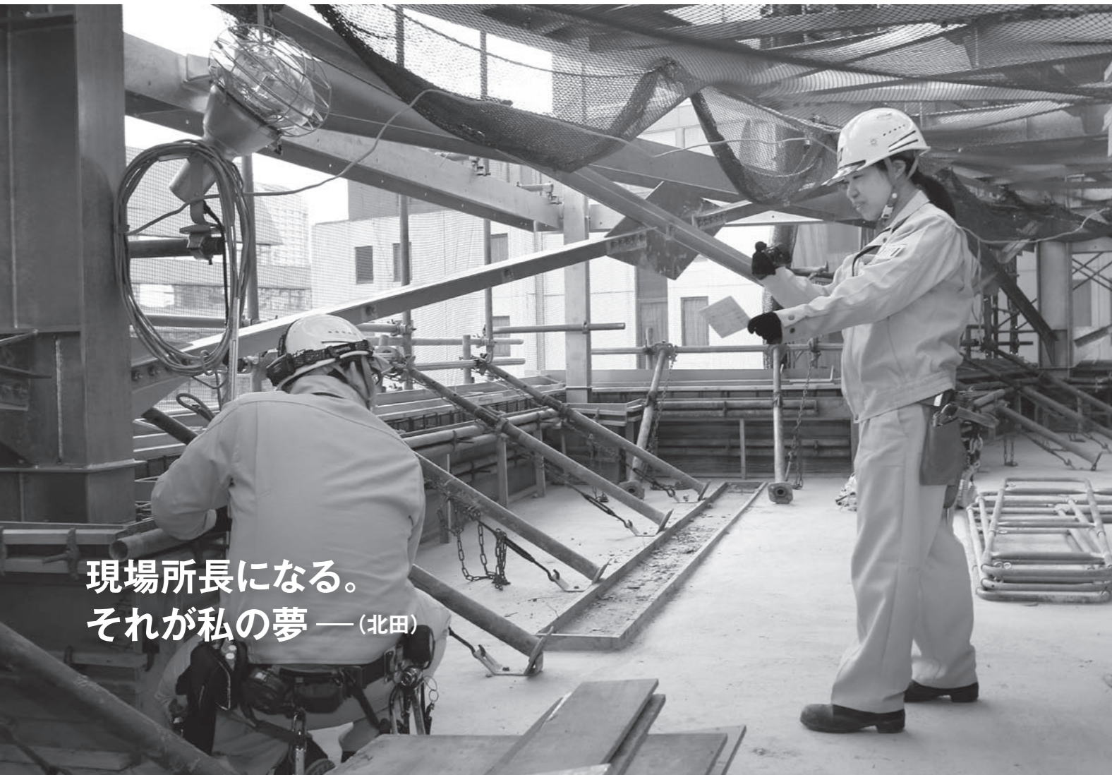
コンクリート打設の前に、型枠や鉄筋の状況を記録写真に収める。この記録が、建物が正しく基準に則って建設されたかどうかの判断材料になる。
